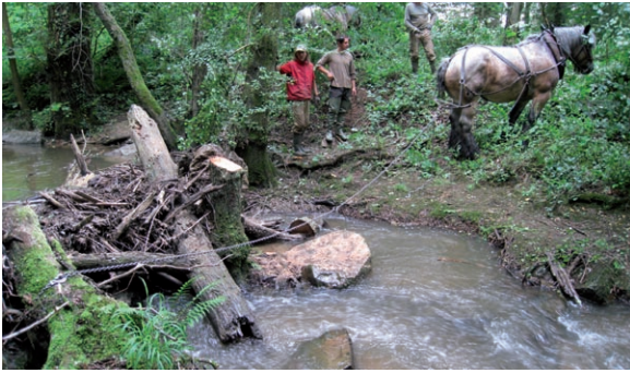
Le mouflage est souvent nécessaire pour décoller les bois "scotchés" par le sable.
